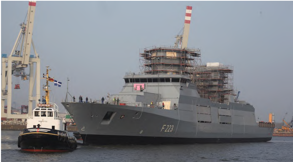
Abbildung 9 Verlegung aus dem Baudock zur Taufe
